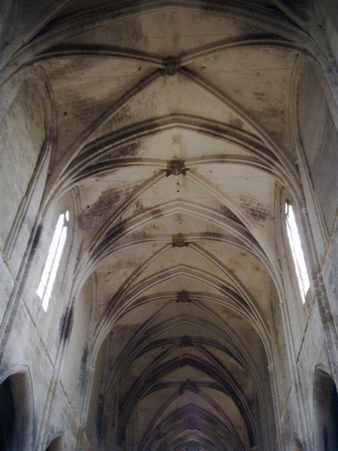
Église, vue des voûtes de la nef
